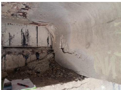
Рис. 1. Разрушение конструкций пролетных строений по причине отсутствия или недостаточной подвижности опорных частей
