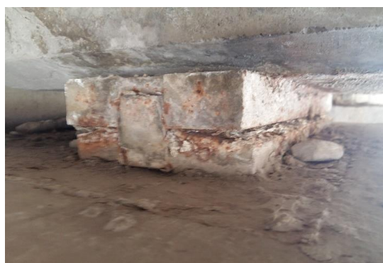
Рис. 1. Разрушение конструкций пролетных строений по причине отсутствия или недостаточной подвижности опорных частей
