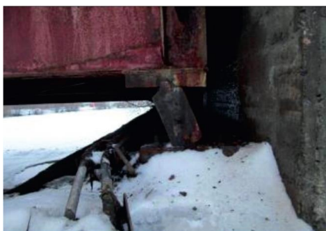
Рис. 3. Угон металлических опорных частей
