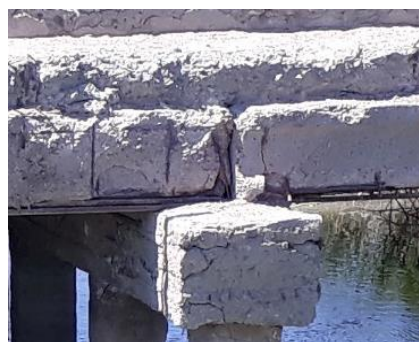
Рис. 5. Дефекты конструкций мостов, возникшие по причине отсутствия опорных частей
