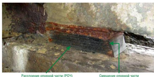
Рис. 4. Дефекты резиновых опорных частей
