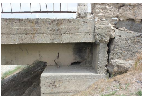
Рис. 5. Дефекты конструкций мостов, возникшие по причине отсутствия опорных частей
